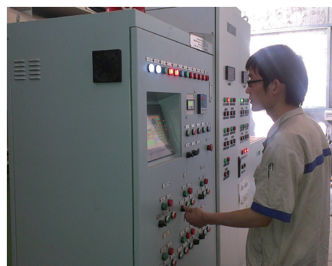
我公司技术人员为巴基斯坦 TBM 柴油机电站项目柴油机安保系统产品进行安装调试
